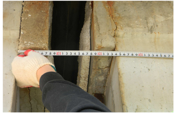
슬래브하면 신축유간 측정
