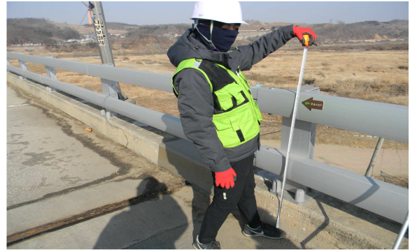
방호벽 제원조사 현황
