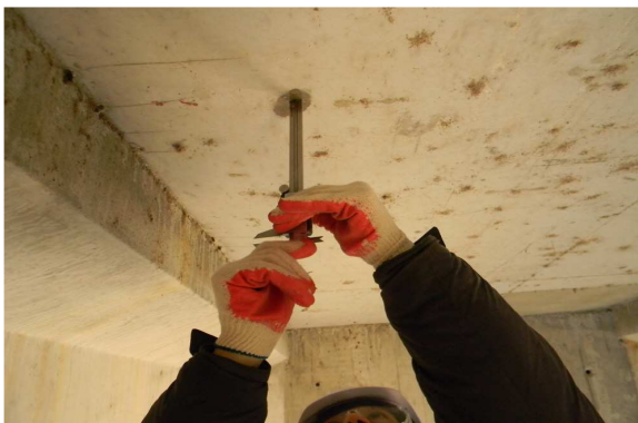
탄산화 측정 현황
