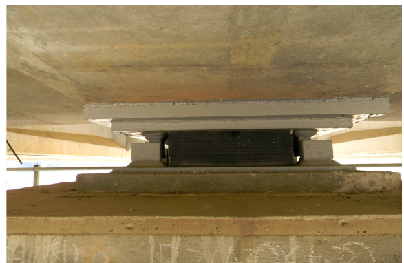
고정단 탄성받침 전경(P2 Sh3)
