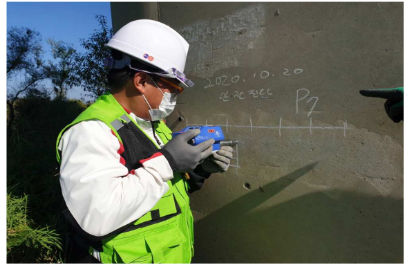
반발경도법에 의한 콘크리트 강도조사 현황
