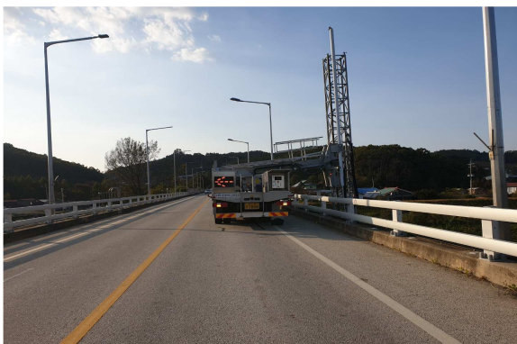
교량점검차를 이용한 현장조사
