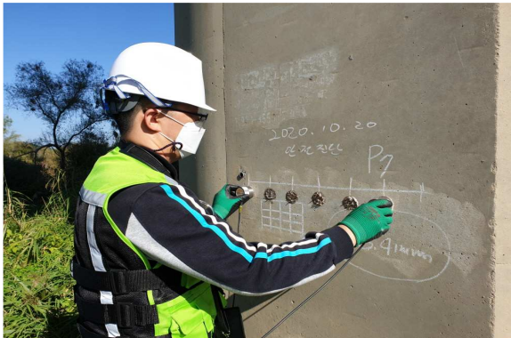
초음파속도법에 의한 콘크리트 강도조사 현황
