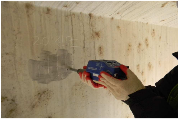
반발경도법에 의한 콘크리트 강도조사 현황
