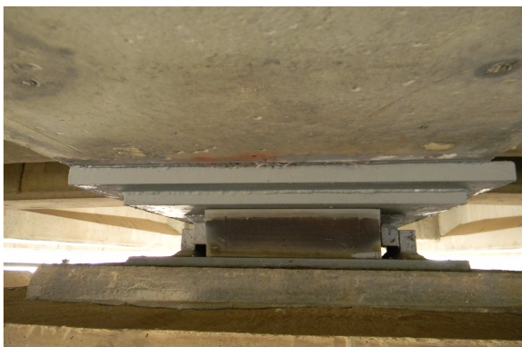
일방향 탄성받침 전경(P19 Sh3)
